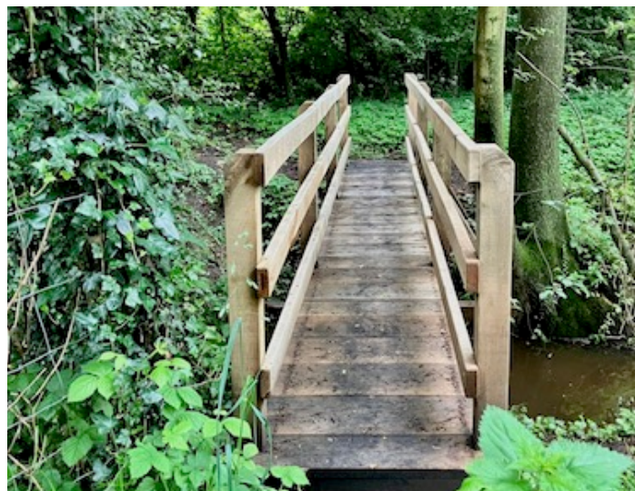
nieuwe brug Jorishof
